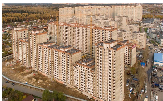
ЖК «Новогиреевский», Московская область «Балашиха-сити»
